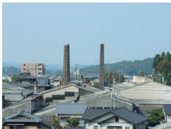
2014（平成26）年 東面より撮影（左：丸型煙突 右：角型煙突）
