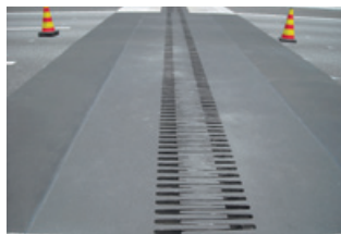
アスクリートキット（速硬化型樹脂系補修材）
