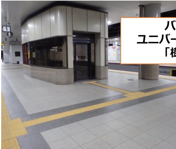
JR新大阪環状線1・2番ホーム
