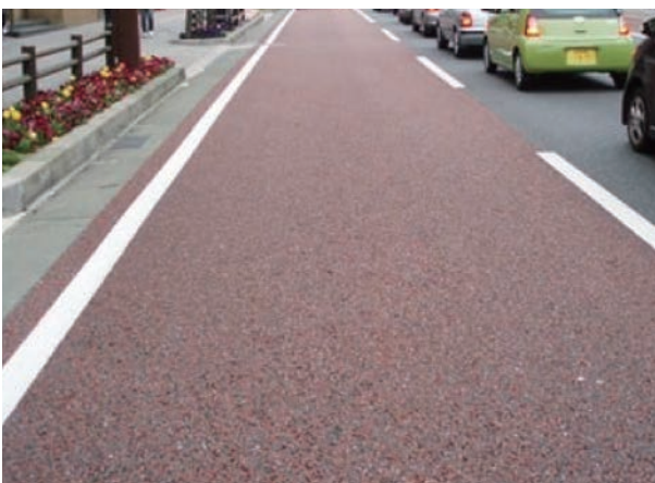
セラサンド(すべり止め舗装・カラー舗装)
